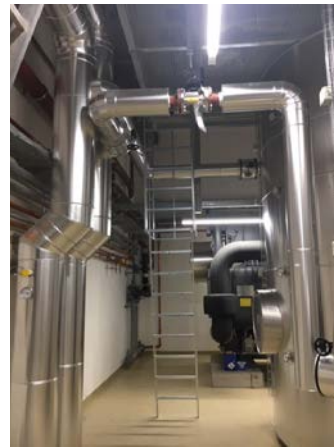
Verrohrung Wärmespeicher
