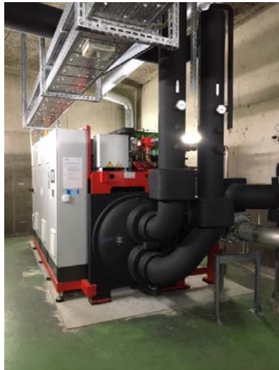
Kältemaschine
