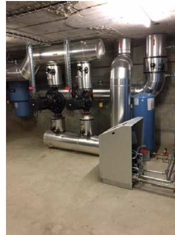
Wärme-Verteilpumpen
