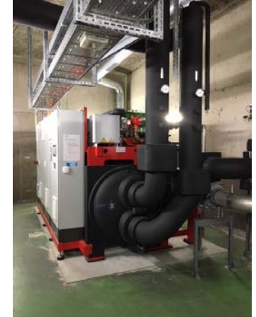
Kältemaschine
