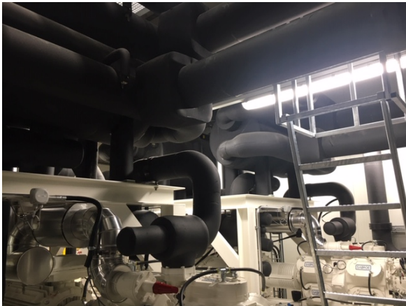
Verrohrung Kompressionskältemaschine
