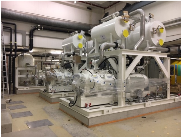
Kompressionskältemaschine
