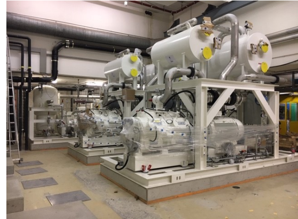
Kompressionskältemaschinen
