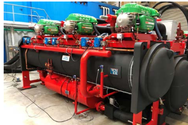
Absorptionskältemaschine
