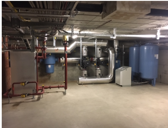
Verteilpumpen Abwärmenutzung
