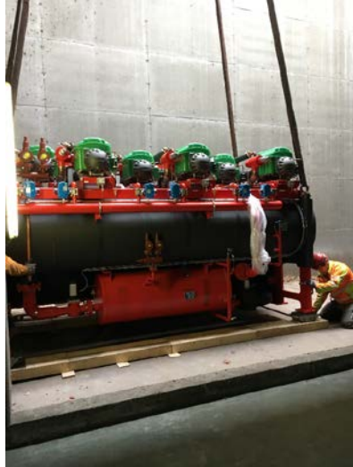
Einbringung Kältemaschine
