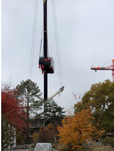
Einbringung Kältemaschine
