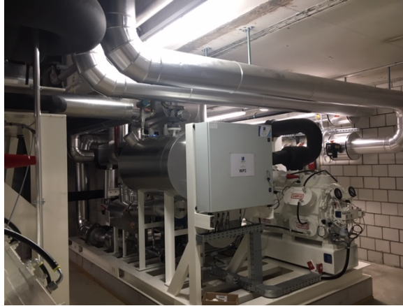
Wärmepumpe
