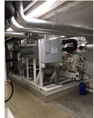
Wärmepumpe
