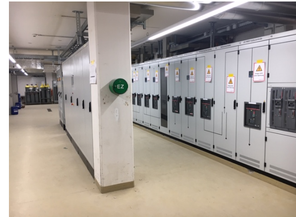
Elektro-Hauptverteilung Kälte
