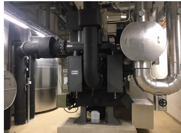
Absorptionskältemaschine
