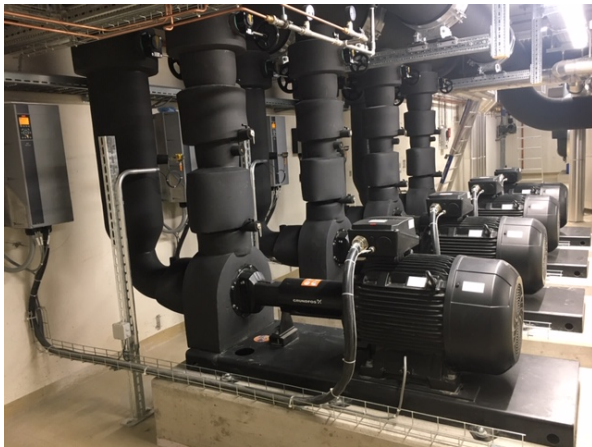
Kälte-Verteilpumpen
